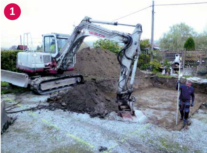
▲ Aushub der Baugrube
