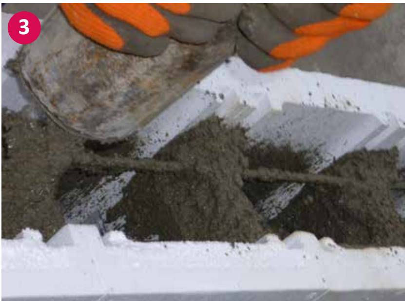
▲ Detailansicht: Ausfüllen der Styroporstein mit dem Beton
