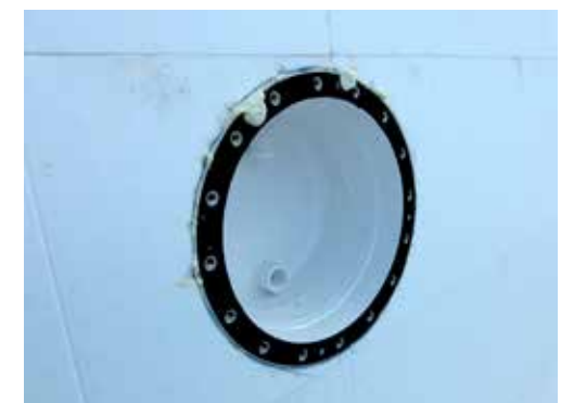
▲ Fertig eingeschäumter Scheinwerfer
