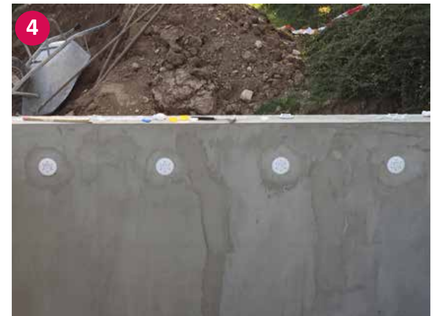
▲ Wichtig: Abdrücken der Rohrleitungen!
