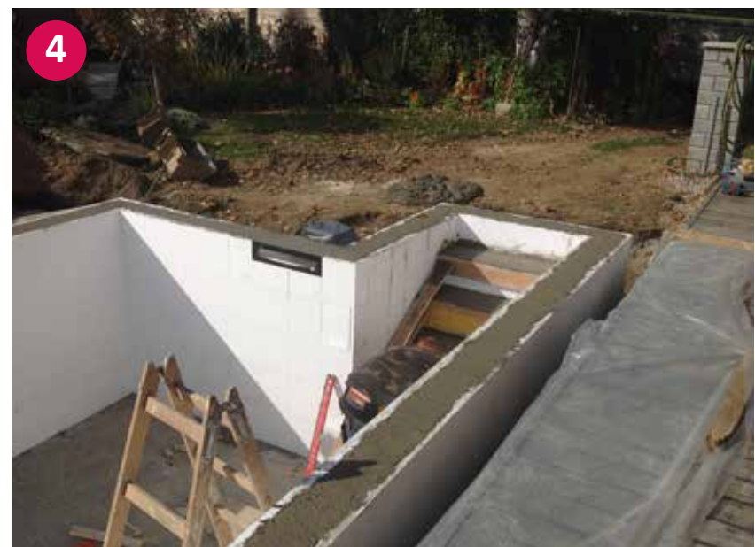
▲ Fertig ausgefülltes Styroporsteinbecken mit Beton
