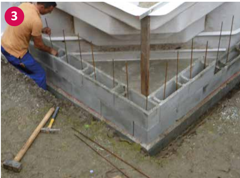
▲ Untermauerung der Ecktreppe
