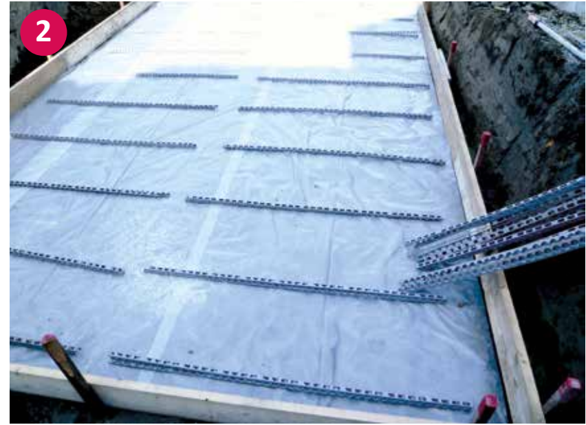
▲ Abschallung der Bodenplatte
